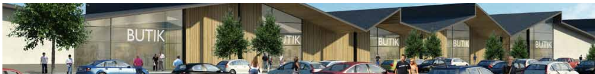
Fasadvy från kundparkeringen, riktning mot nordväst
